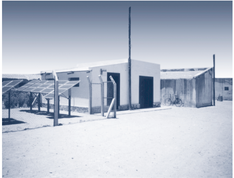
Sistema híbrido (fotovoltaico térmico) con red de distribución
