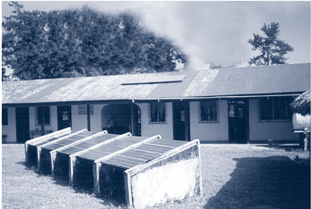
Paneles fotovoltaicos en uso
